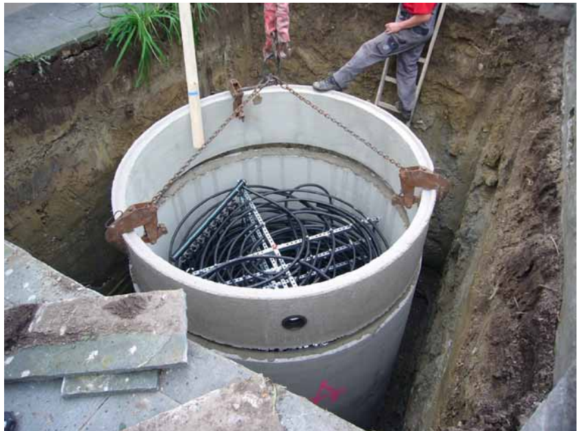
Die Montage eines Eisspeichers im Erdreich
