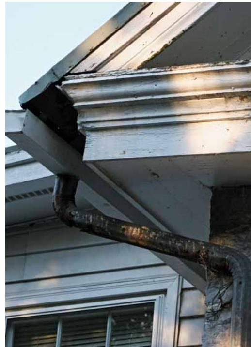
Diese Verziehung reduziert das Abflussvermögen der Fallleitung
