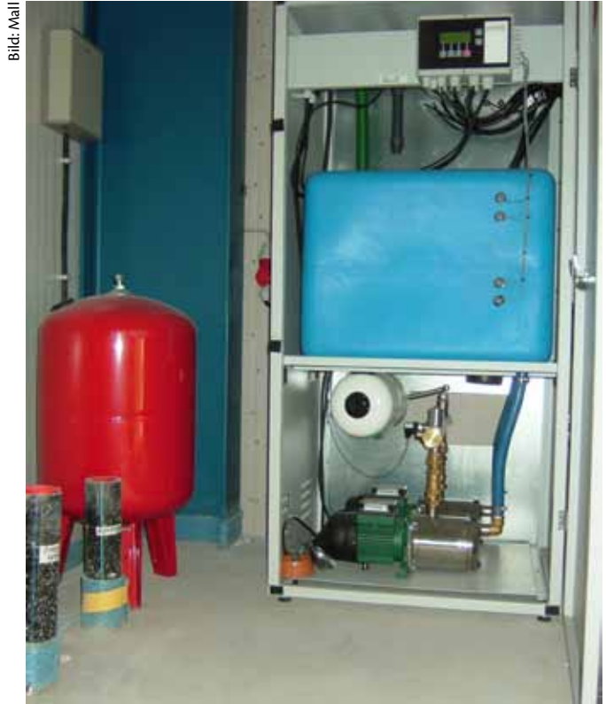
Komplettsystem Druckerhöhungsanlage Tano XL mit integrierter Trinkwassernachspeisung, Vorlagebehälter 200 l (blau), Druckausgleichsbehälter 100 l (rot) und Zubringerpumpe mit Zubehör im unterirdischen Betonfertigteilsspeicher
