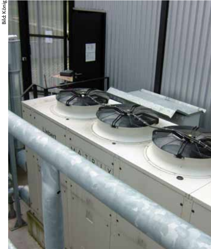
Verdunstungskühlung mit Regenwasser bei Hüttinger Elektronik, Freiburg
