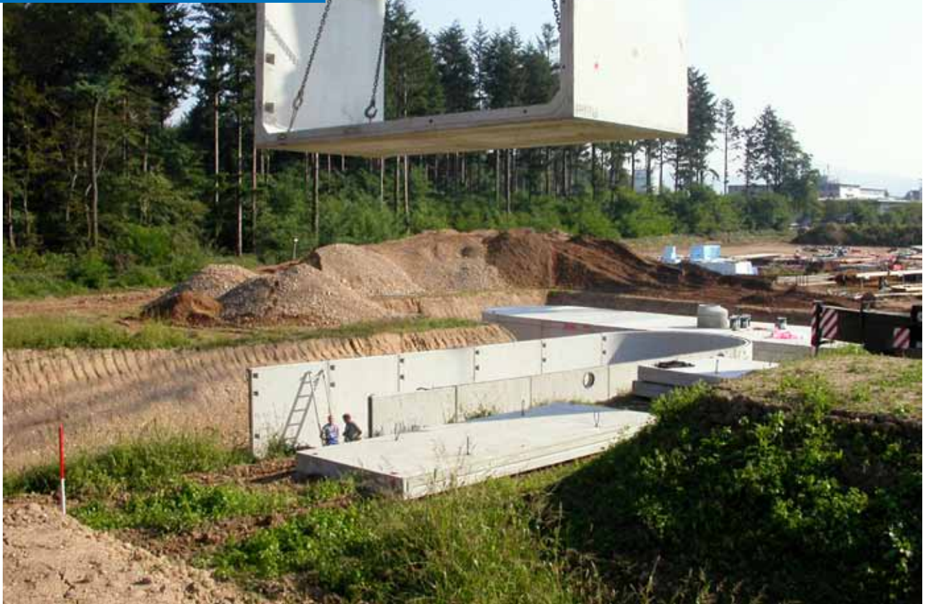
Unterirdische Betonfertigteilspeicher für Regenwasser zur Produktions- und Gebäudekühlung, 2 x 300 m 3 Fassungsvermögen, bei Hüttinger Elektronik, Freiburg
