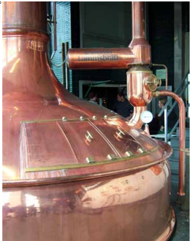
Neumarkter Lammsbräu, Kühlung der Bierproduktion mit Regenwasser
