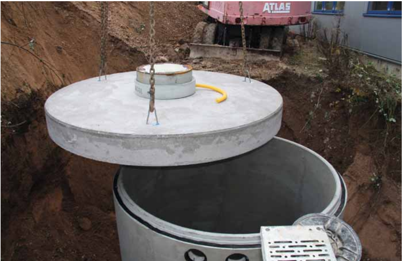
Pufferspeicher-Hülle aus Stahlbeton-Fertigteilen, Schachtabdeckung
