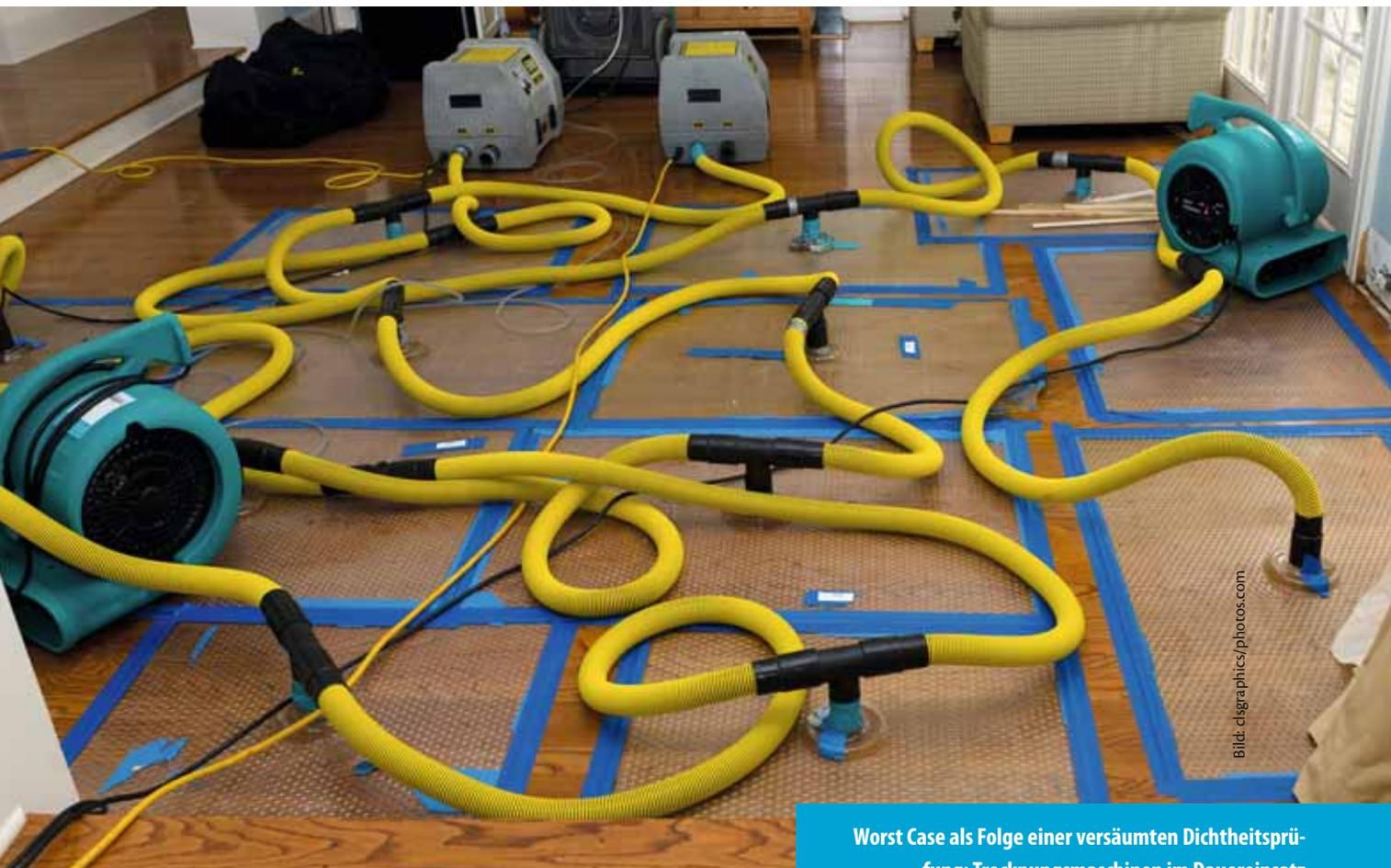
Worst Case als Folge einer versäumten Dichtheitsprüfung: Trocknungsmaschinen im Dauereinsatz
