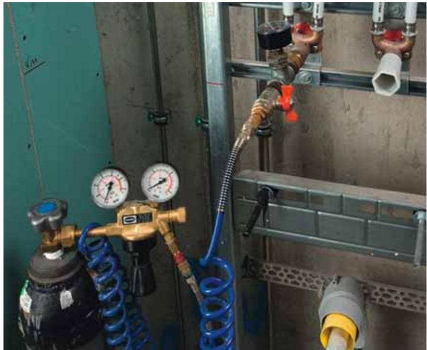
**Inerte Gase beim Einsatz während einer Dichtheitsprüfung**
