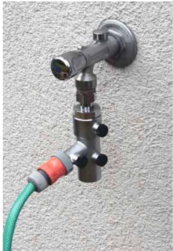
Wege gehen. Auch ein Hochdruckreiniger mit chemischen Zusätzen sollte normgerecht nur mit einem Systemtrenner an eine Zapfstelle angeschlossen werden, um ein Rückdrücken oder Rücksaugen der Reinigungsflüssigkeit in das Trinkwassersystem zu vermeiden.
