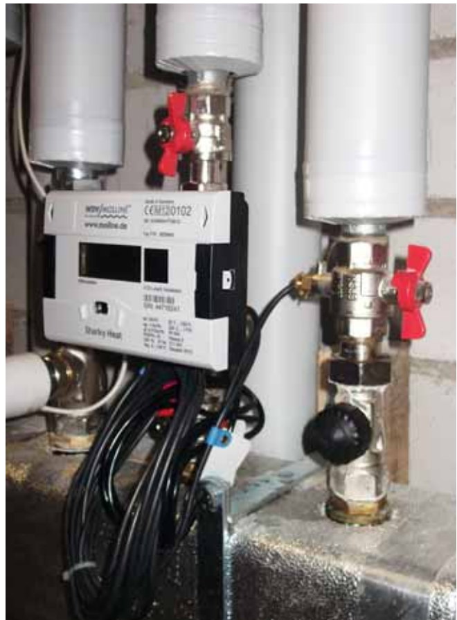
Eingebauter Ultraschallwärmehähler
