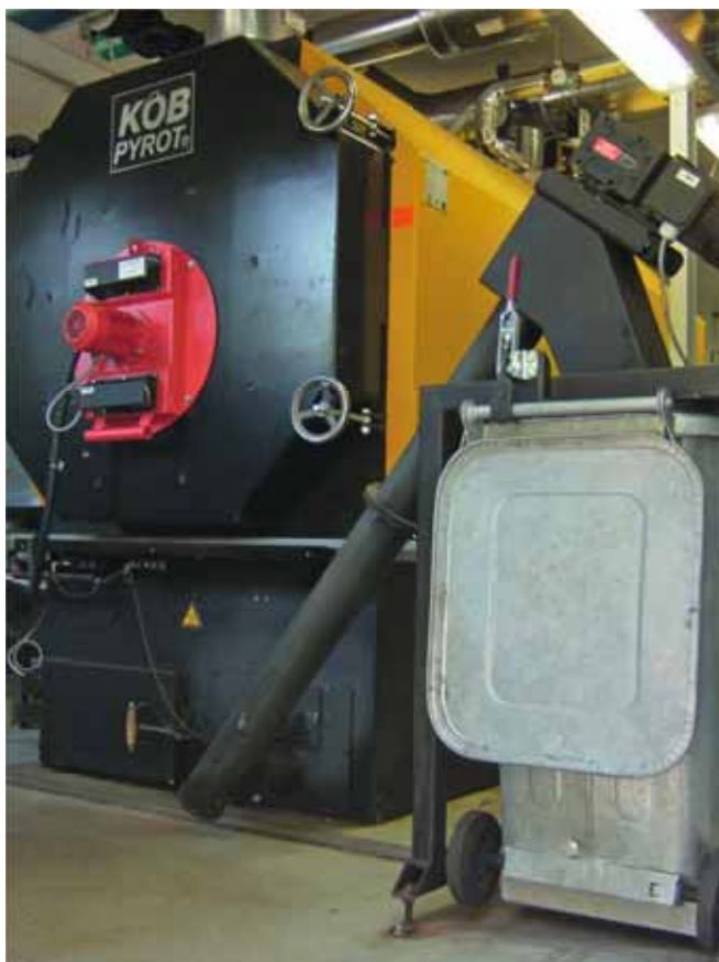
Pelletheizkessel mit automatischer Asche-Austragung
