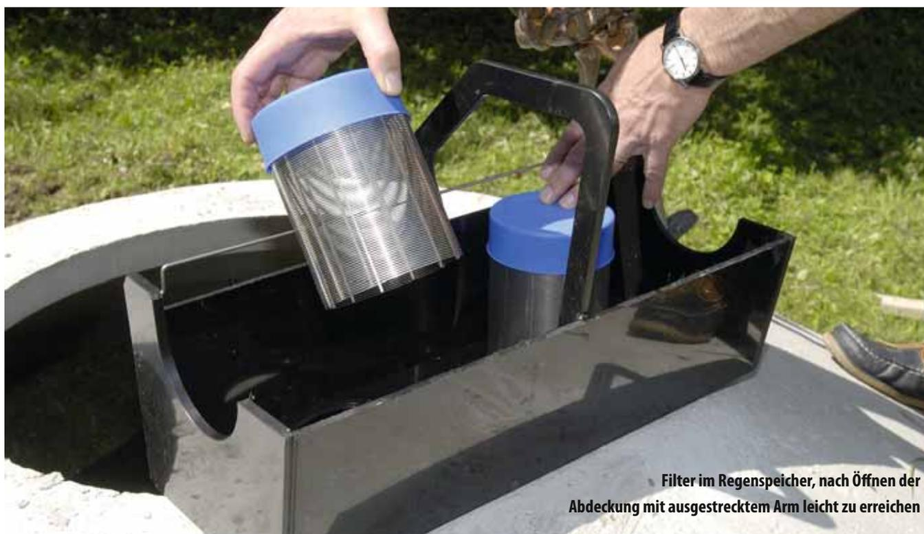
Filter im Regenspeicher, nach Öffnen der Abdeckung mit ausgestrecktem Arm leicht zu erreichen
