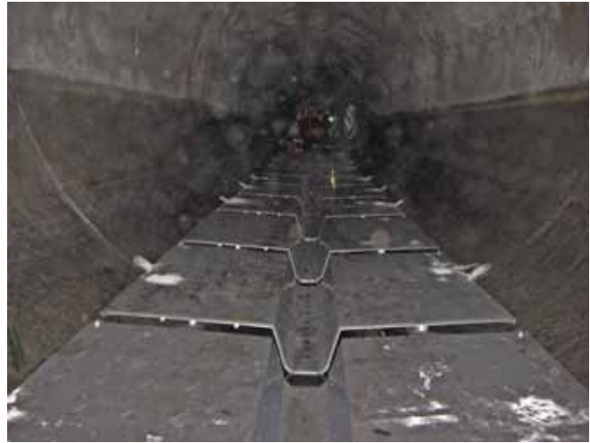
Auf der Kanalsohle befestigte Thermliner-Elemente aus Edelstahl, modular erweiterbar und demontierbar
