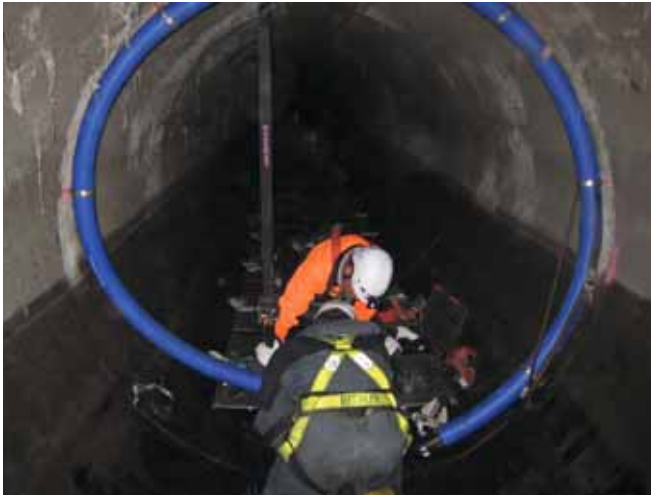
Das Montageteam von Uhrig Kanaltechnik im Einsatz. Überströmte Thermliner-Fläche 1,272 m 2 /m
