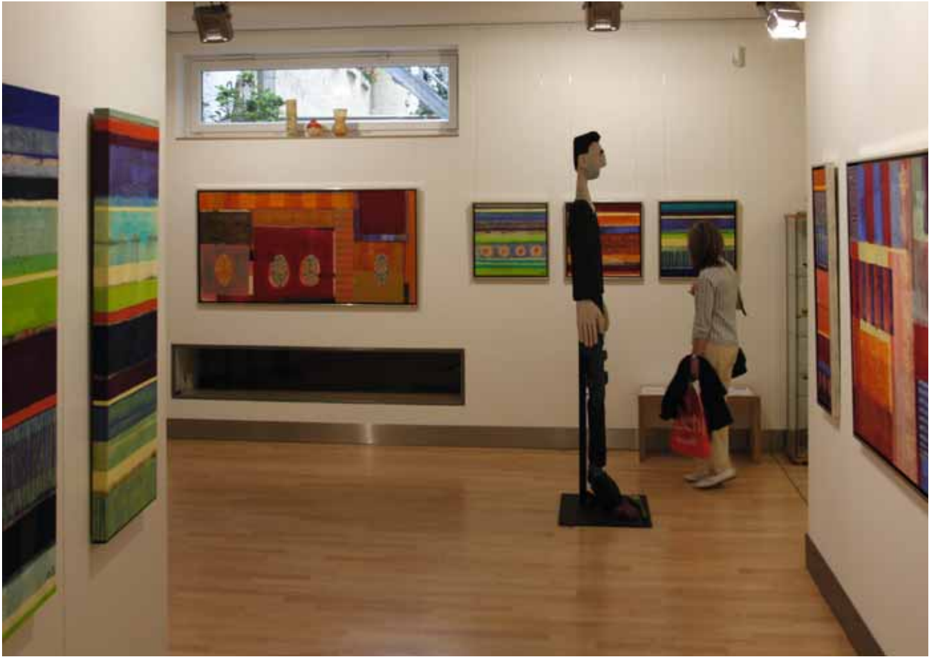
Kassettengeräte sorgen in der Wiesbadener Galerie für angenehme Temperaturen. Den Luftaustausch übernehmen Gebläsekonvektoren mit Mischluftbetrieb.
