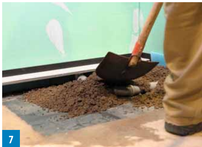
Der Estrich muss mit leichtem Gefälle bündig an den Dünnbettflansch der Rinne angebunden und verdichtet werden
