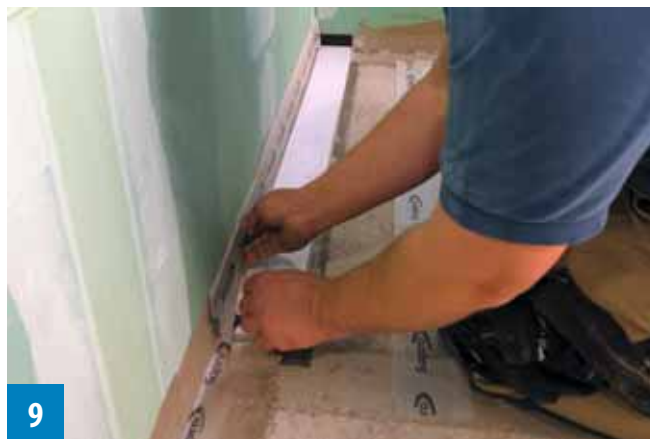
Alle Übergänge müssen zuerst mit Dichtungsband versehen werden, danach wird mit der Dünnbettabdichtung gestrichen. Diese wird ebenfalls auf dem Dünnbettflansch und auf dem Estrich aufgetragen
