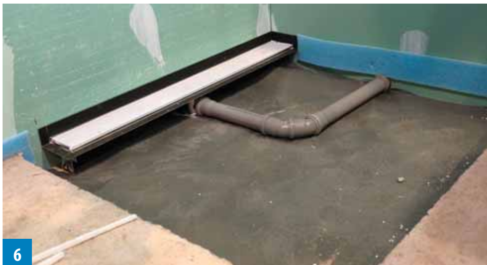
6 Nach dem Einbringen der Trittschalldämmung und der Gleitfolie erfolgt der Anschluss der Rohre an die Entwässerungsleitung
