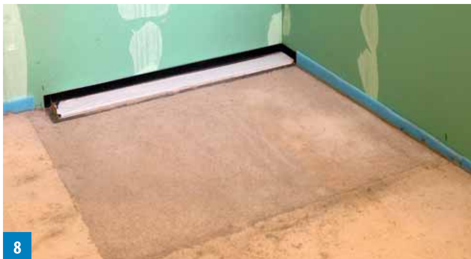
Nach der Aushärtung ist eine Dünnbettabdichtung den Herstellerangaben entsprechend auszuführen
