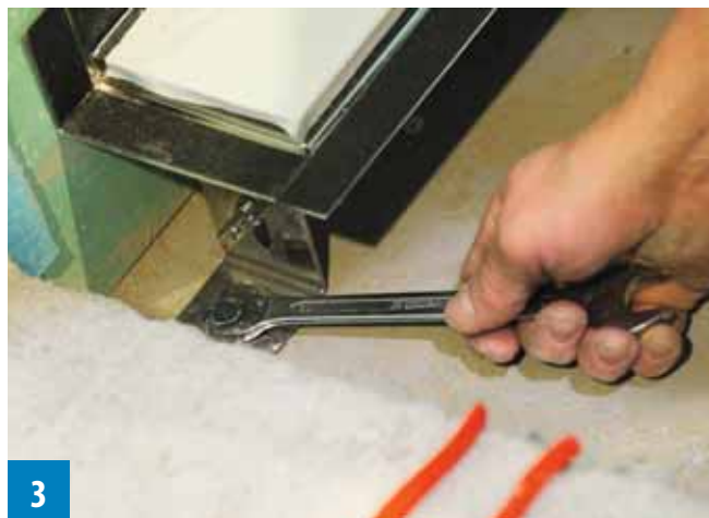
3 Die Füße zur Höhenverstellbarkeit der Duschrinne ACO Showerdrain lassen sich zur Fixierung des Rinnenkörpers auf dem Rohbeton verschrauben
