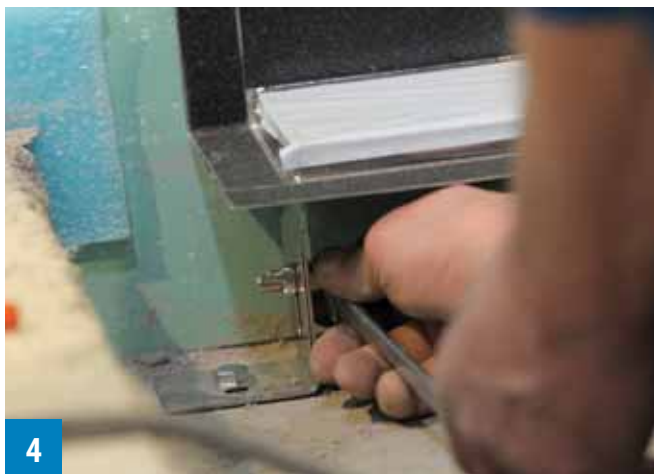
4 Nach Lockern der beiden seitlichen Flügelschrauben lässt sich die Duschrinne ACO Showerdrain in der Gesamthöhe anpassen
