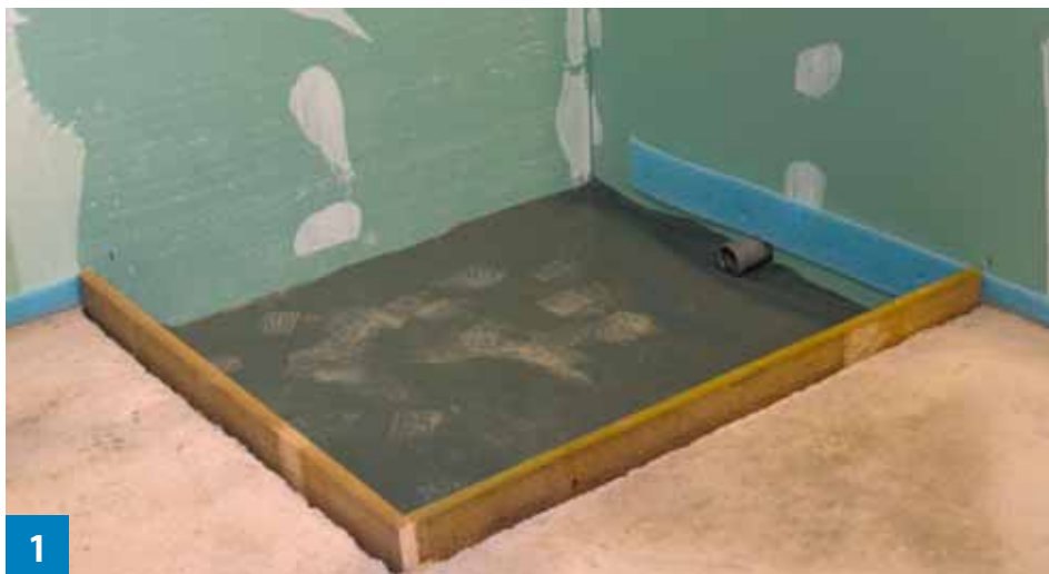
1 Der Einbauort der Duschrinne muss vor Beginn der Montage gut gereinigt werden. Der Rohbeton ist dazu staubtrocken vorzubereiten
