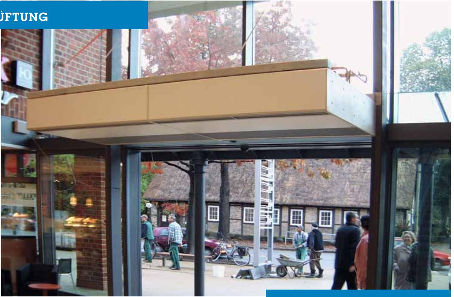
Luftschleieranlagen ermöglichen die Abschirmung zwischen warmer und kalter Umgebung
