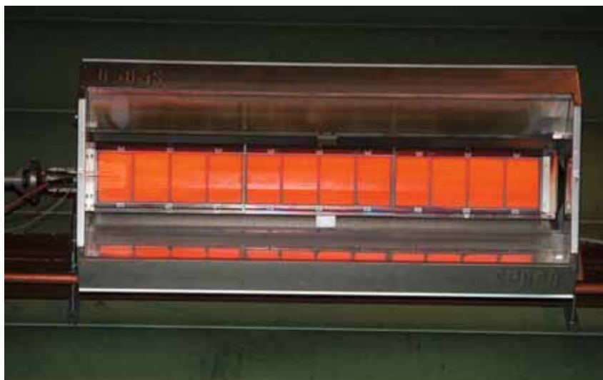
Einer der vier Hellstrahler oberhalb der Empore
