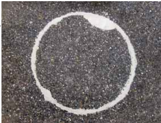
Das verschlossene Schlüsseloch mit nur 65 cm Durchmesser nach vollendeter Arbeit
