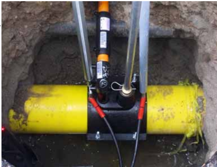
Durch eine moderne Schweißung wird der Hausanschluss mit der Versorgungsleitung verbunden
