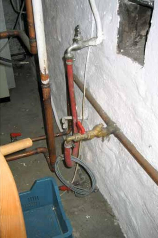
**Freiwillig wird man keinen Schluck aus dem Wasser des Heizungssystems trinken. Warum also lässt man trotzdem diese unzureichende Sicherung zum Trinkwassersystem zu?**
