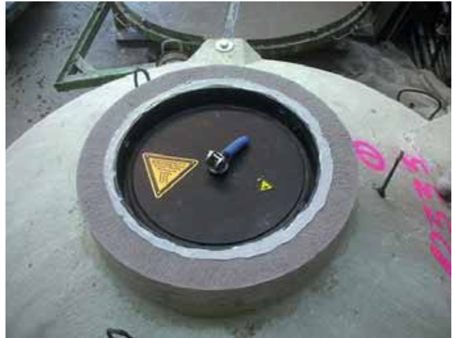
Abdeckung mit zwei Verschlüssen und Entwässerung des Zwischenraums der beiden Dichtungsebenen bei eventuell entstehendem Kondenswasser
