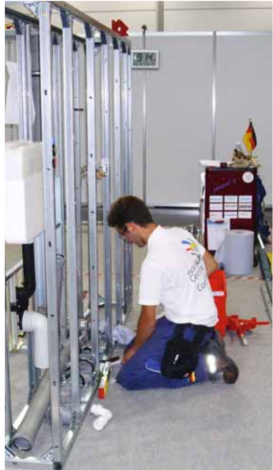
Jung-Geselle Köfer beim Ausrichten der Installationselemente – hier kam es auf jeden Millimeter an
