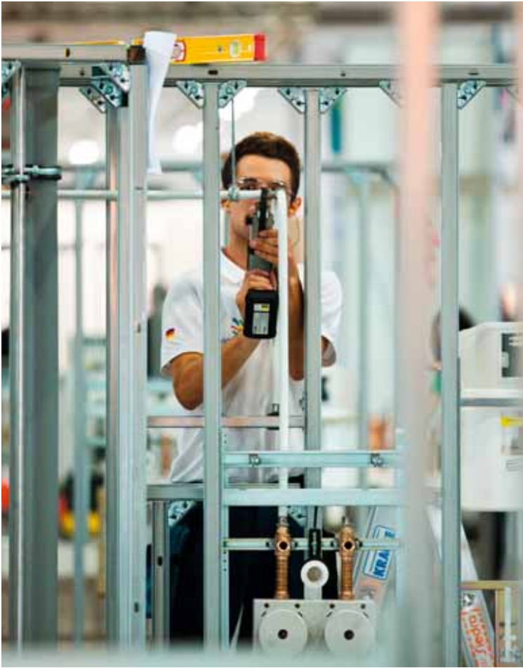
Exakt und sauber gearbeitet – so soll eine Installation aussehen: Matthias Köfer verpresst hier gerade einen der 2500 Viega-Fittings
