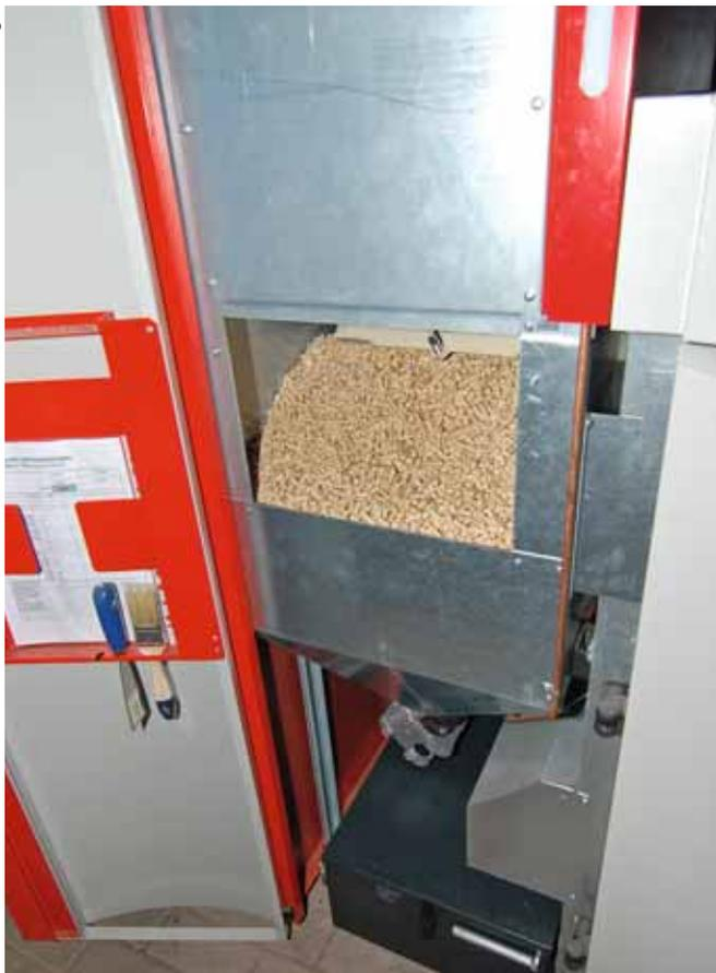
**Einige Pellet-Kessel verfügen über einen Vorratsbehälter direkt neben dem Kessel. Von hier wird der Nachschub zum Brenner befördert.**
