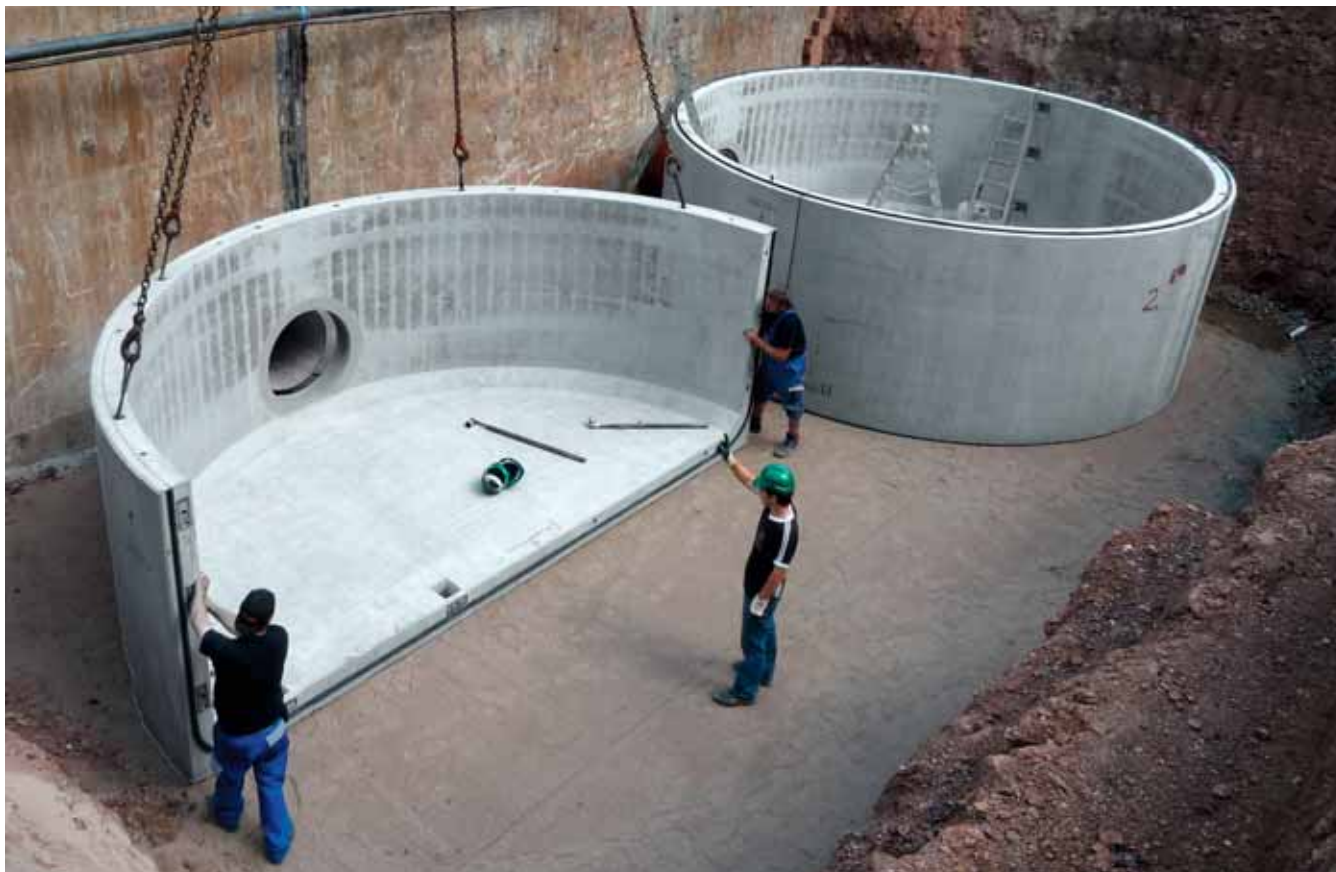
Versetzen der ersten drei Stahlbeton-Fertigteile. Sichtbar sind die Öffnungen für die Förderschnecken zur Entnahme des Brennstoffes in Richtung Heizzentrale
