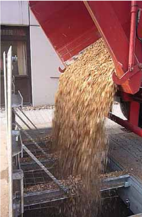
Befüllen eines unterirdischen Hackschnitzelbehälters
