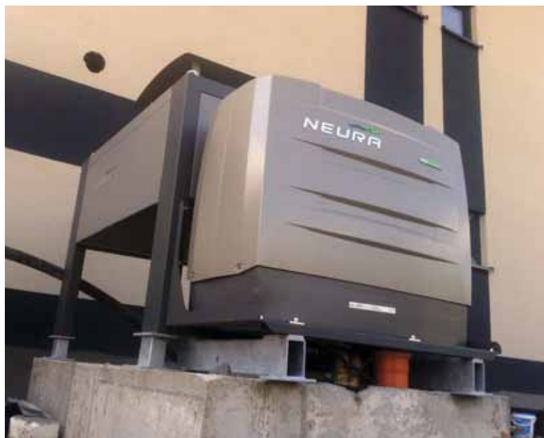
Zentrales Element des Plusenergiehauses ist eine Luft/Wasser-Wärmepumpe Neura NDA, die im Marktumfeld Spitzenleistungswerte liefert
