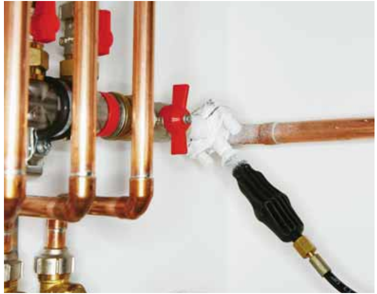
Das Einfrieren mit CO 2 erfordert wenig Vorbereitung und kaum Hilfsmittel
