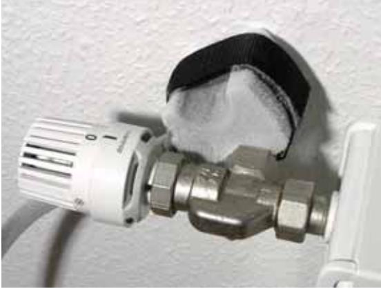
Der Einfrierkopf des Systems Rems Frigo 2 im Einsatz
