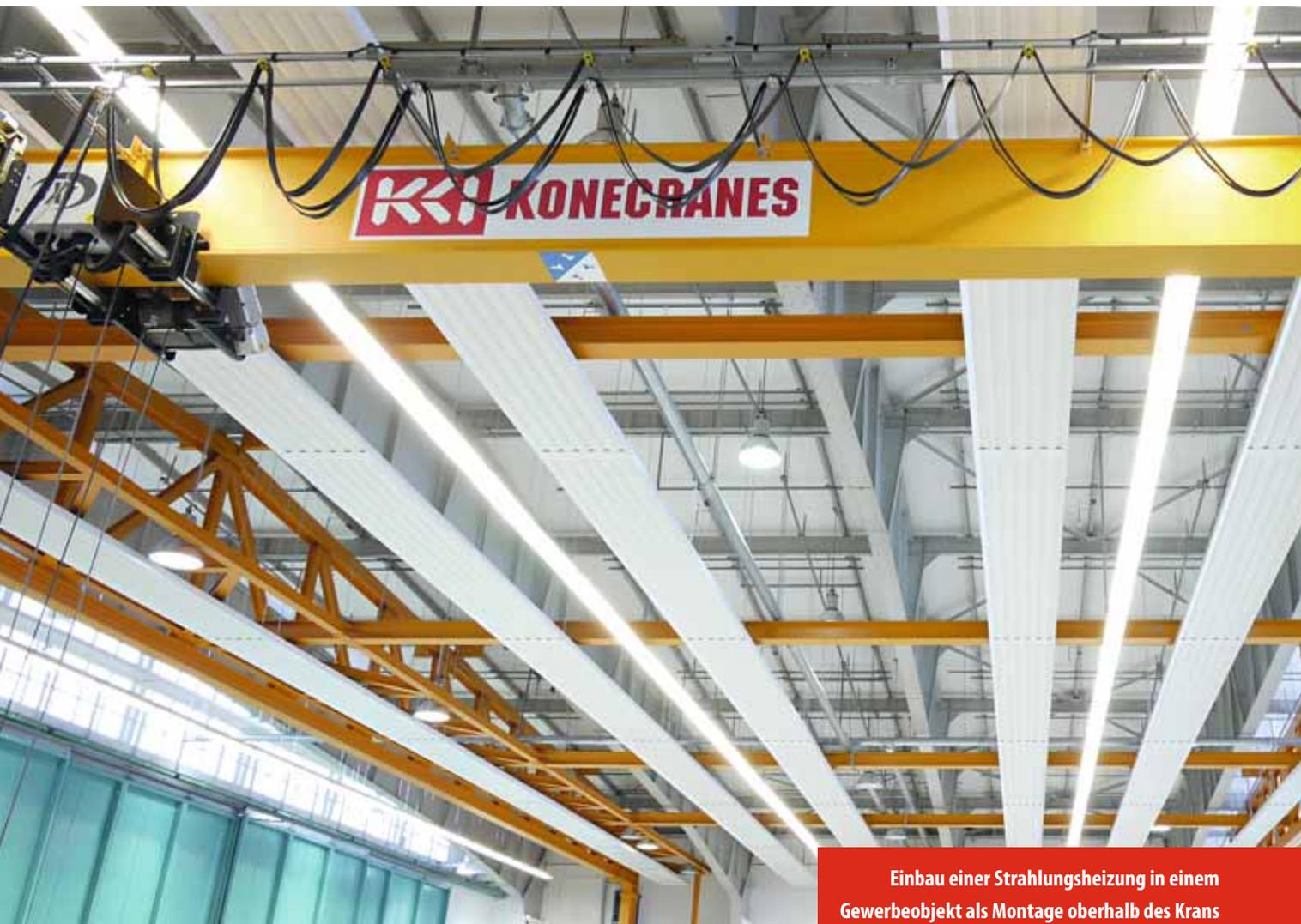
Einbau einer Strahlungsheizung in einem Gewerbeobjekt als Montage oberhalb des Krans und parallel zur Beleuchtungseinrichtung
