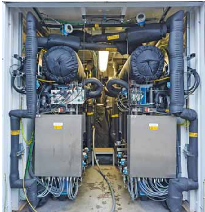
Elektrolyseur: Wasserstoffherstellung aus Wasser und Strom
