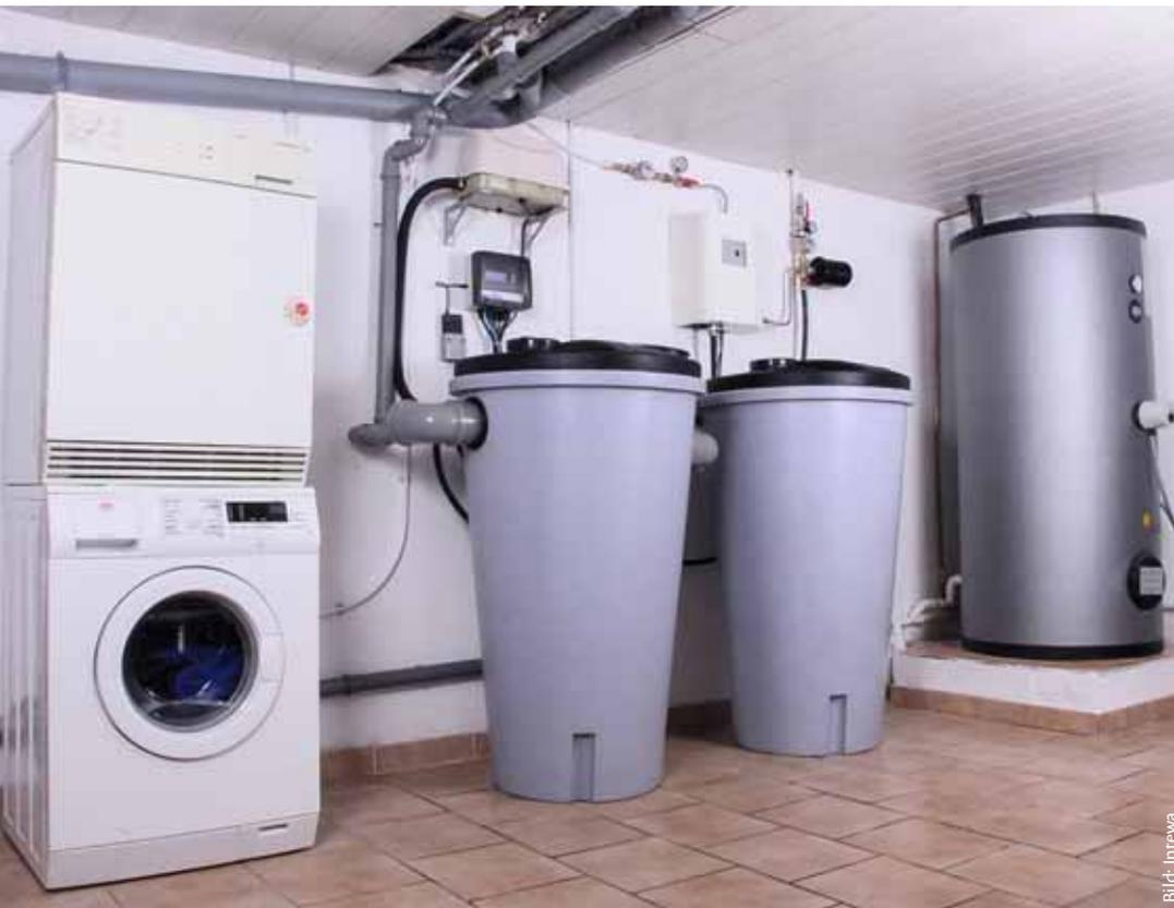
**Grauwasserrecycling-System inkl. Wärmespeicher. Die Waschmaschine ist an das Regenwassernetz angeschlossen**
