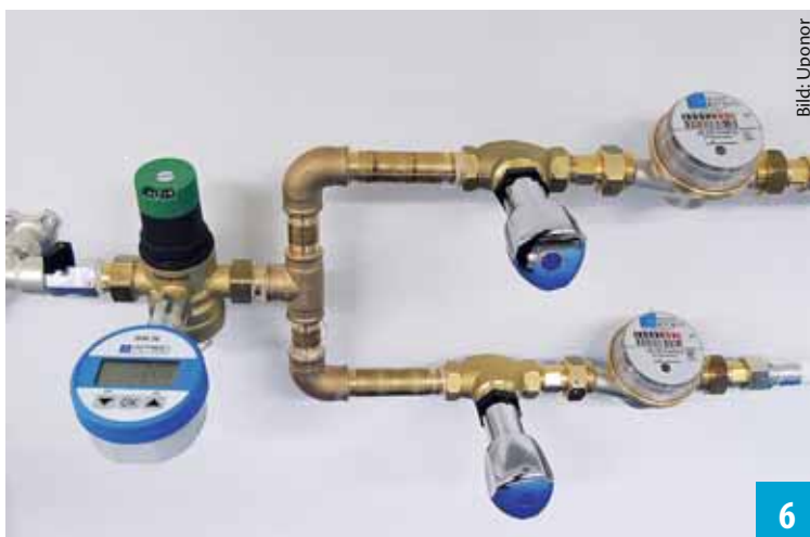
Prüfstandmessung: Für beide Rohrsysteme wurde der gleiche Eingangsdruck eingestellt
