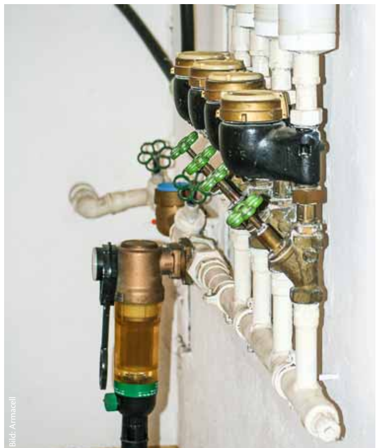
Trinkwasseranschluss im Keller
