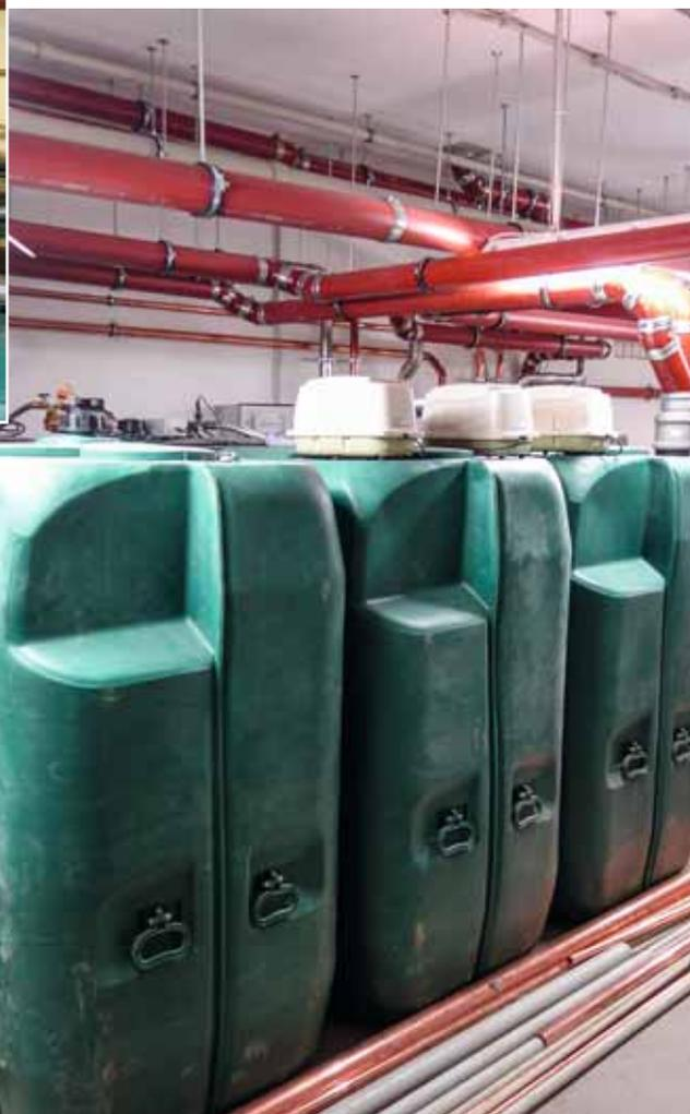
Grauwasseranlage im Technikraum im Untergeschoss mit 3 x 2000 l Fassungsvermögen
