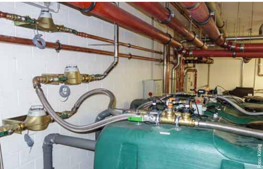
Grauwasseranlage im Technikraum des Untergeschosses, flexible Anschlussleitungen mit Wasserzähler zu den Verbrauchsstellen bzw. Nachspeisung für Trinkwasser bei Leerstand
