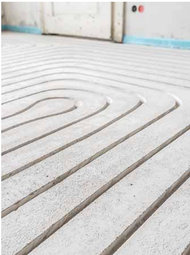
Nach Abschluss der Fräsarbeiten ist der Estrich geeignet zur Aufnahme einer effizienten Fußbodenheizung
