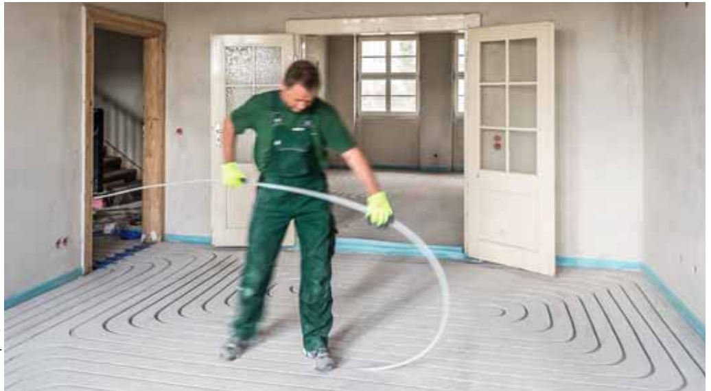
Kunststoffheizungsrohre Klimapex 15 x 1,8 mm werden ohne zusätzliche Befestigungen eingelegt
