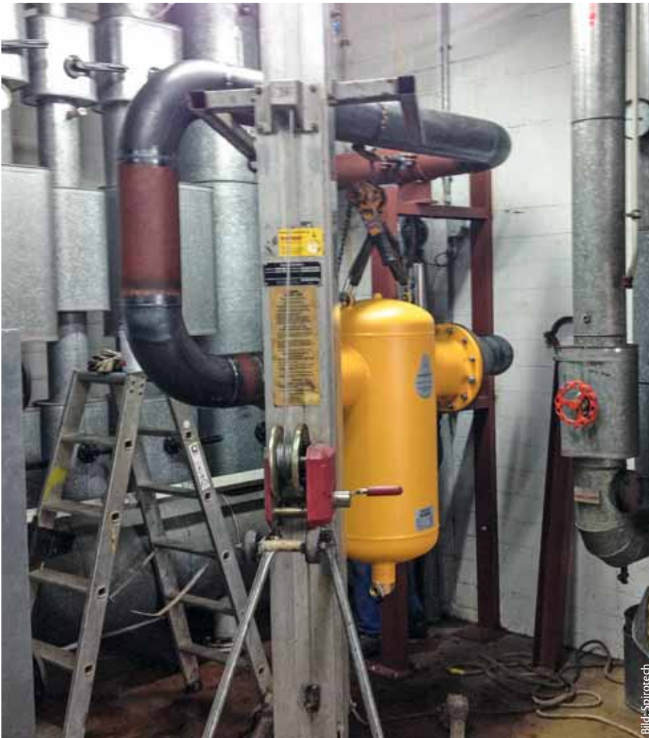
Während der Montage: Der SpiroTrap-Magnet wird in den Rücklauf der Heizung eingebunden, hier mittels einer neu gelegten Schleife in der Rohrführung. Später sind alle Elemente wärme gedämmt
