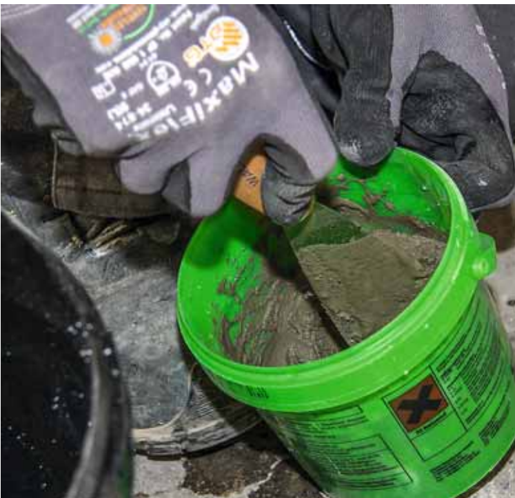
3. Sopro Racofix 2000 wird angerührt
