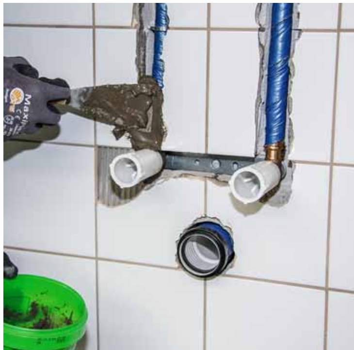
4. Sopro Racofix 2000 wird zum Fixieren und Verspachteln der Leitungen verwendet
