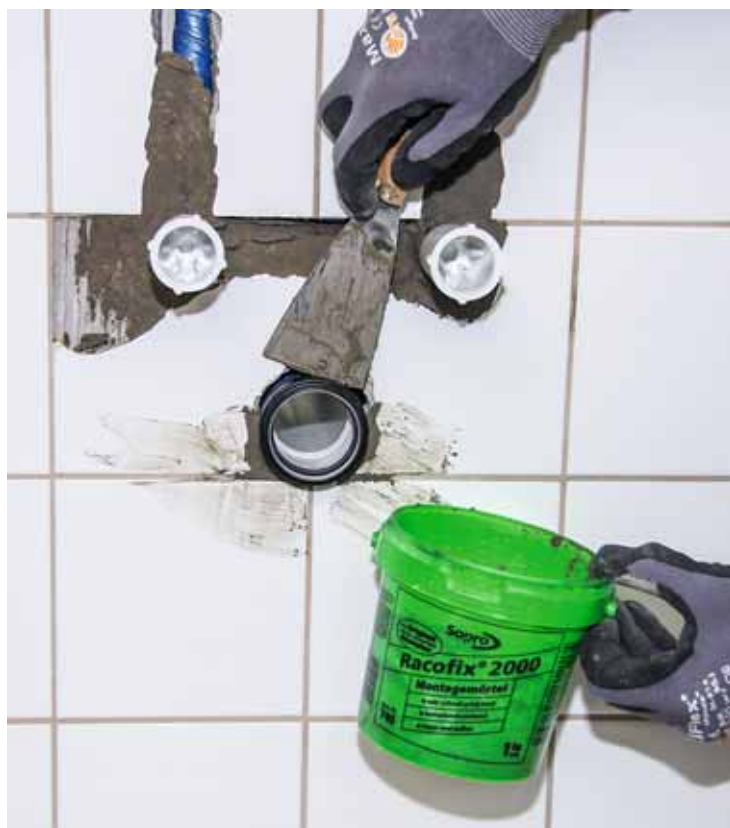
5. Auch an der Abwasserleitung wird eine Verspachtelung vorgenommen
