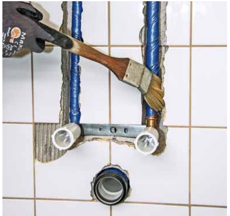
2. Zunächst wird der Untergrund von Staub befreit und angefeuchtet
