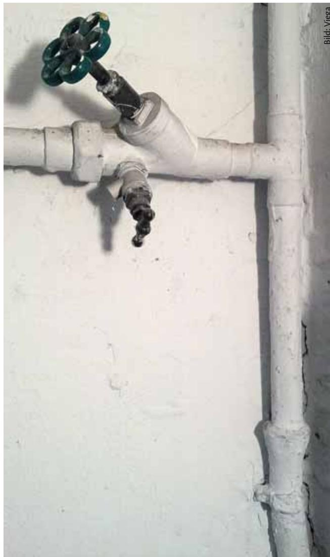
**Abb. 1: Die Grenzwerte für Blei sind schon lange einzuhalten. Eine verdächtige Zuleitung wie diese, mit der trichterförmigen Muffe (im Bild unten rechts, kurz oberhalb der Schelle) weist auf eine Bleileitung hin, die unbedingt entfernt werden sollte**
