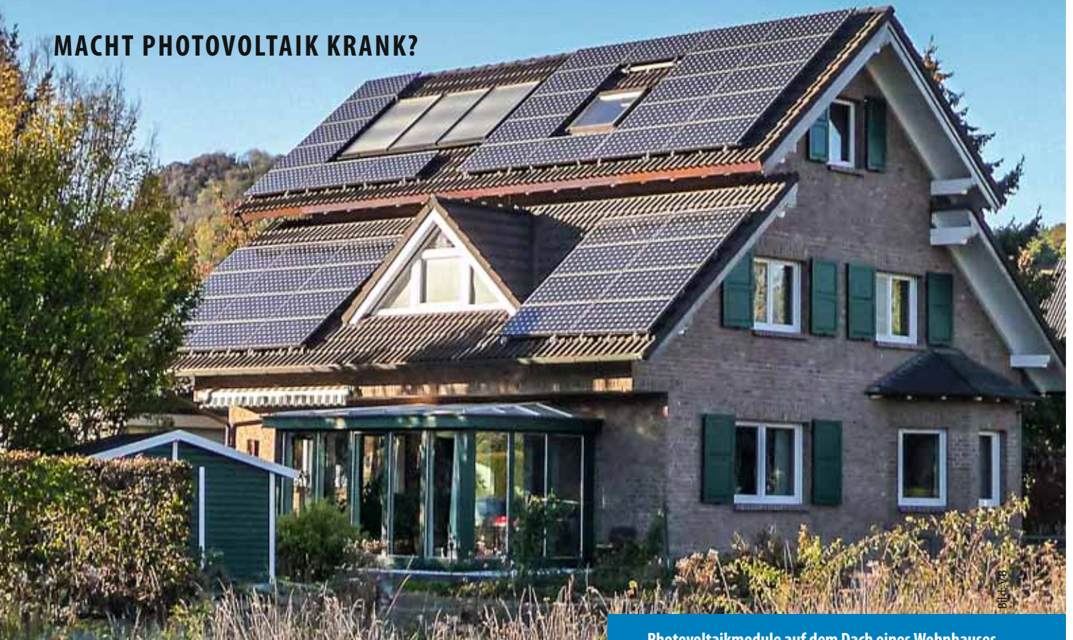
Photovoltaikmodule auf dem Dach eines Wohnhauses
