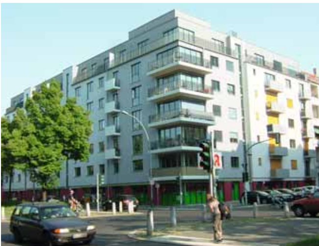
Beispiel für die Nutzung von Wärme aus Abwasser: Berlin-Prenzlauer Berg, Arnimplatz
