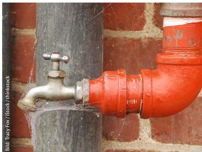
**Sieht zwar cool aus, ist aber ganz und gar nicht zweckmäßig. Die Zuleitung zu dem Kleinstverbraucher in dieser übertriebenen Dimension ist ganz sicher nicht das Ergebnis einer Rohrnetzrechnung nach DIN 1988-300**
