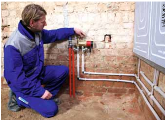
Die Renovis-Panels-Leitungen aus PE-Xa-Rohr, Fittings, Pumpengruppe und Verteiler stammen systemkonform von Uponor
