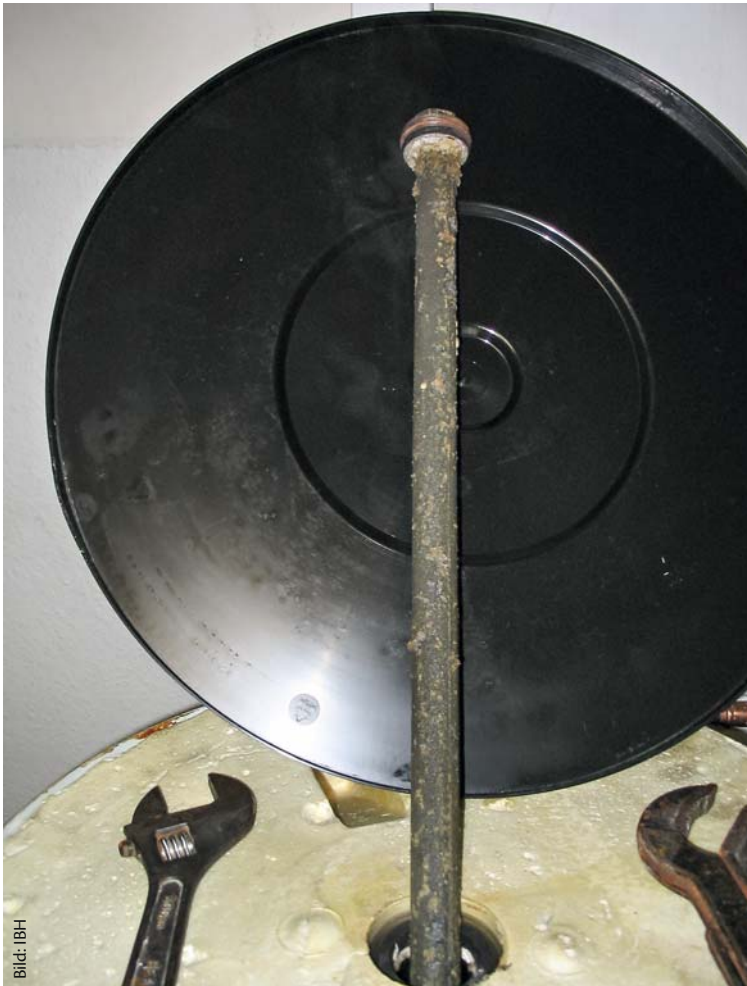
Diese optische Überprüfung zeigt eine fast makellose Opferanode
