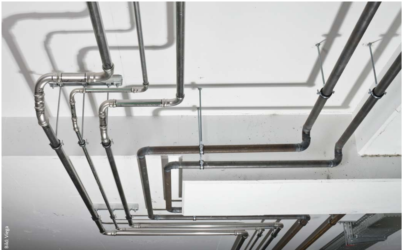
Jede Richtungsänderung stellt eine Entschärfung der gesamten Längenausdehnung dar. Es ist also keine Schikane, die Rohrführung nicht nur geradeaus führen zu lassen
