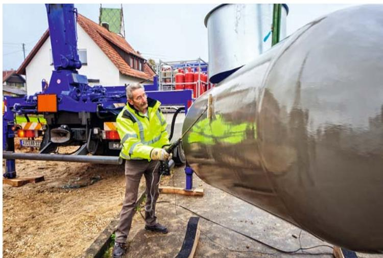
**Vor seiner Einlagerung in die Grube wird der Behälter mittels einer Stromspannungsprüfung auf seinen Korrosionsschutz geprüft. Dadurch fallen eventuell entstandene Transportschäden sofort auf**
