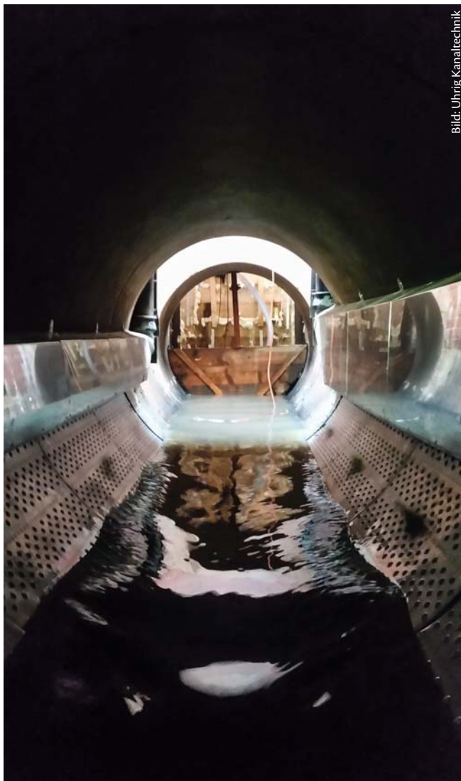
Die 86 m lange Wärmeübertragerstrecke im Mischwasserkanal mit 1,5 m Durchmesser liefert die Wärme für den 1. Bauabschnitt des neuen Wohnquartiers Alter Stadthafen
