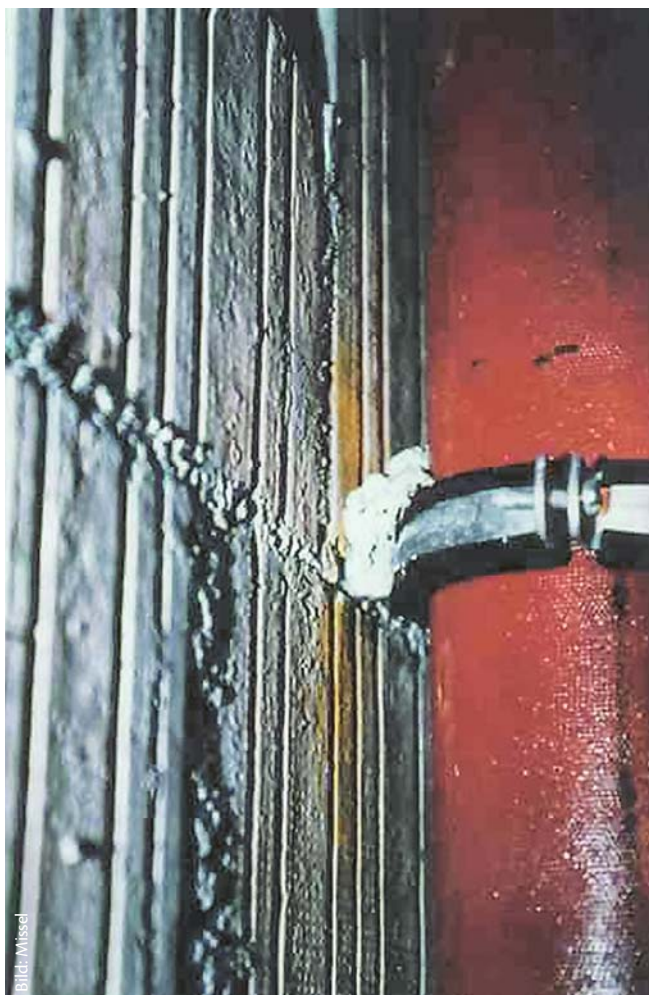
Ein Klecks Mörtel verbindet das Gußrohr schalltechnisch mit der Wand
