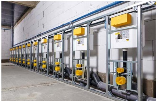
**Für die Reihen-WC-Anlage kam das Vorwandssystem Steptec und für die Anschlussleitungen das Rohrleitungssystem Profipress zum Einsatz. Danach hat der Trockenbauer die Wände raumhoch verkleidet.**
