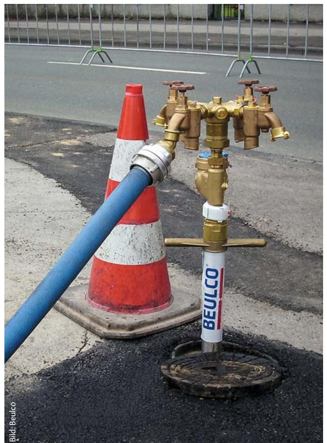
Ein Standrohr mit Zähler und Systemtrenner BA
