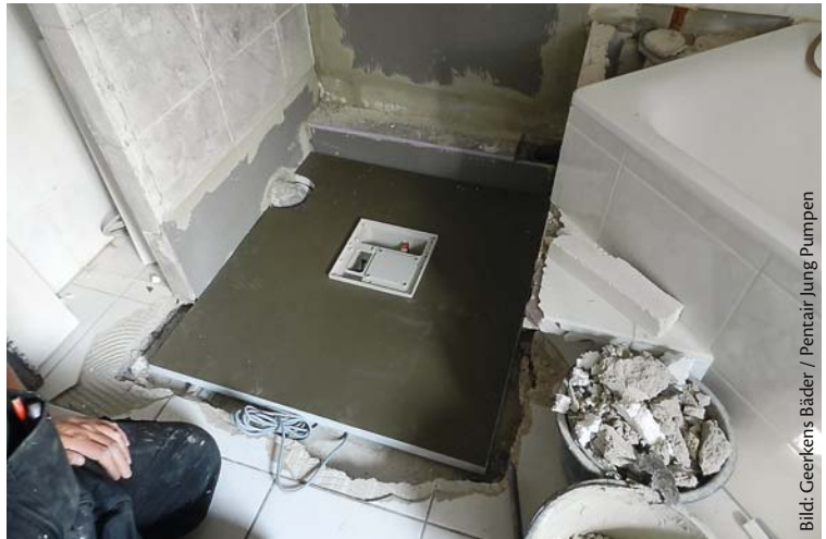
Die Installation des Duschtassenelements mit integriertem Plancofix erleichtert den Einbau
