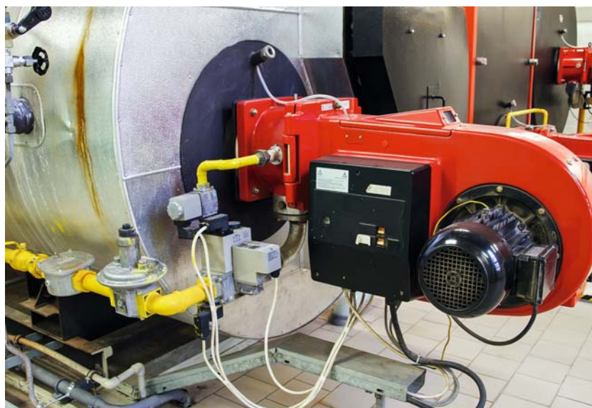
Ein Gasgebläsebrenner hat keine Ahnung von Lambda. Die richtige Einstellung ist daher Ihrem Geschick und Verständnis überlassen
