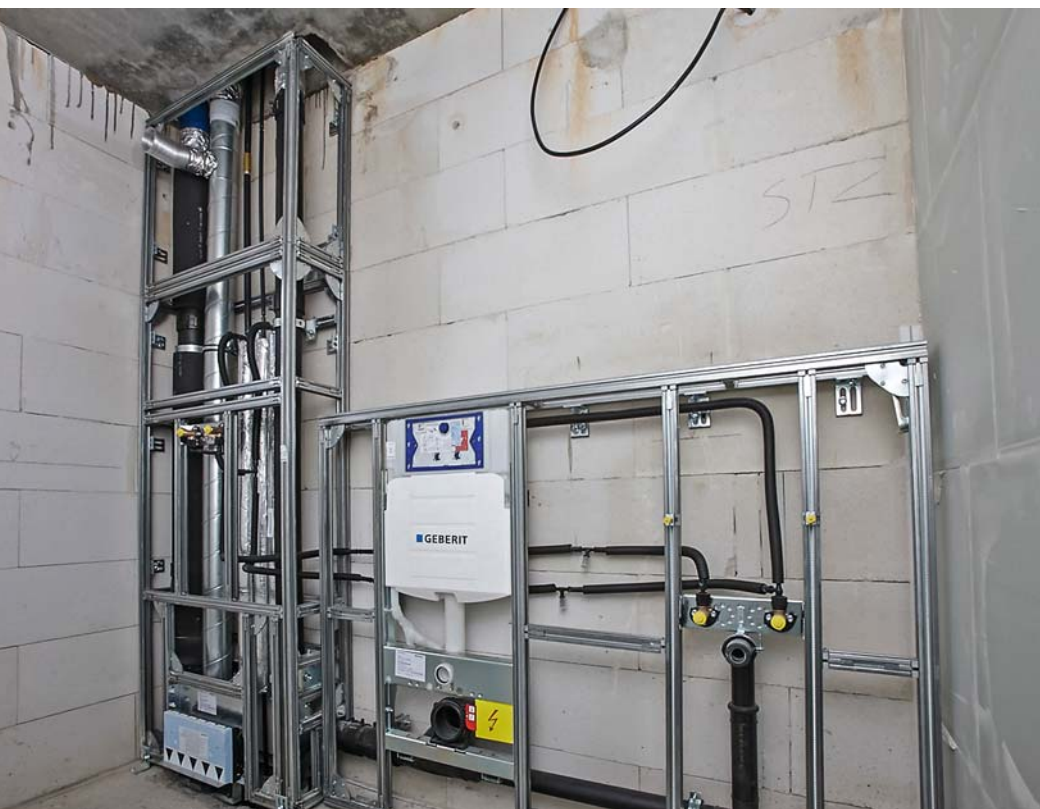
Mit diesem Installationssystem von Geberit lassen sich ohne Nassbauarbeiten freistehende Installationswände realisieren
