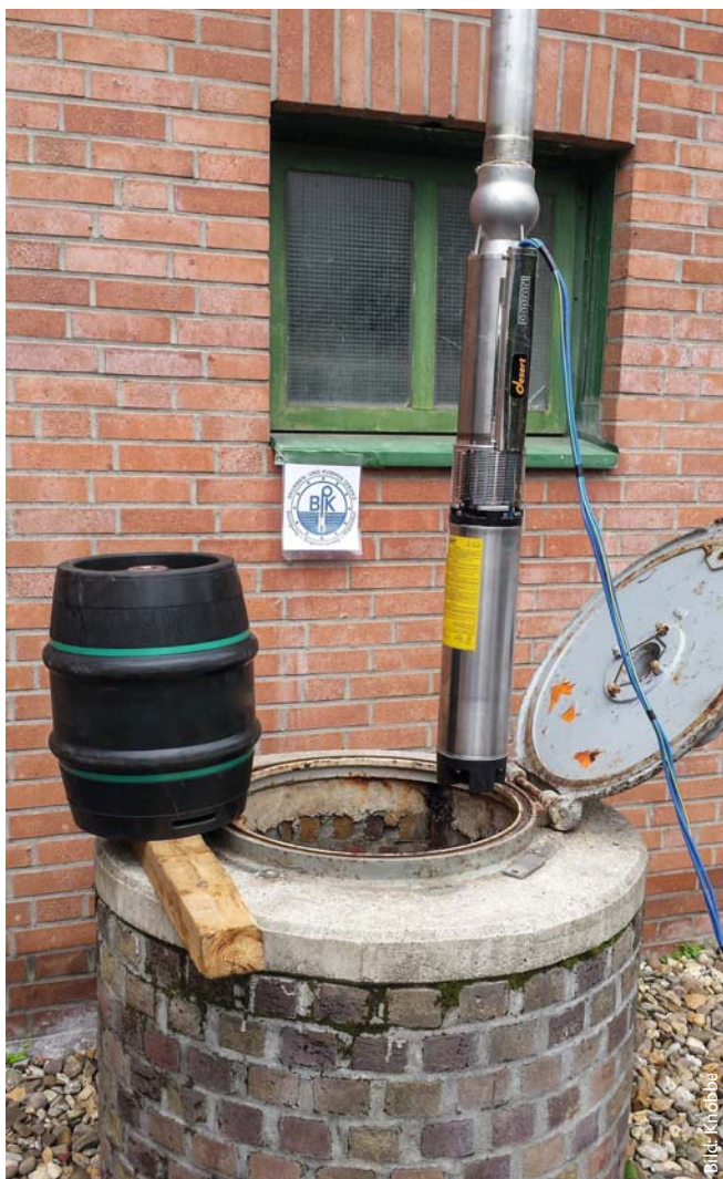
Einfahren der Pumpe samt Steigrohr in den Brunnen: der letzte Arbeitsschritt vor der Wiederinbetriebnahme
