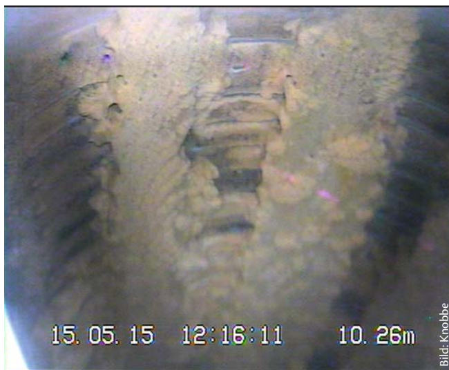
Diese erheblichen Ablagerungen an der Brunnenwand vor der Sanierung gilt es rechtzeitig zu entfernen
