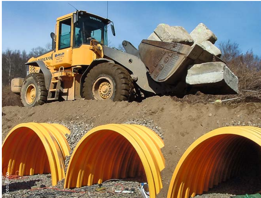
Belastungstest: Da die Fläche darüber als Feuerwehzufahrt dient, ist bei diesem Objekt die Belastbarkeit der Tunnelkammern besonders wichtig
