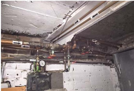
In kaum einem Bereich der technischen Gebäudeausrüstung sind die Bastler dieser Welt so konstant auf dem Holzweg wie bei der Verbindung zwischen Trink- und Heizungswasser. Zur Nachspeisung reichte diesem Wurschtelkönig eine starre Rohrverbindung und ein Durchgangshahn.
