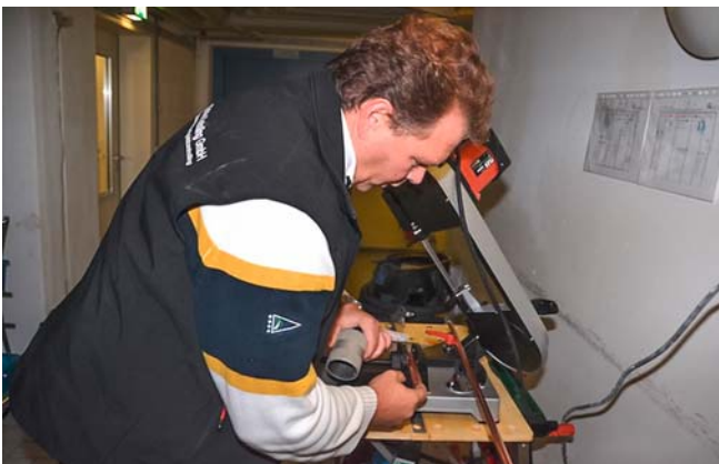
Schritt 5: Überprüfung der fachgerechten Entgratung durch Inaugenscheinnahme und Tasten
