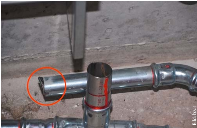
Schräge Schnittkante, wie hier bei einem C-Stahl-Rohr
